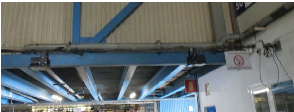
Detall pas de la canonada d'aigua en ponts
